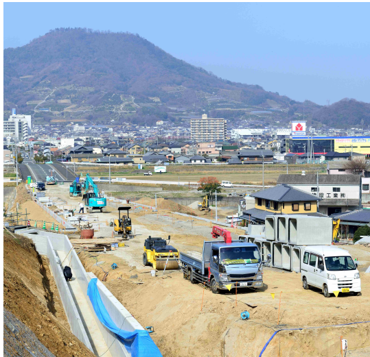
着々と工事が進む木太鬼無線 鶴市工区＝3月12日撮影
